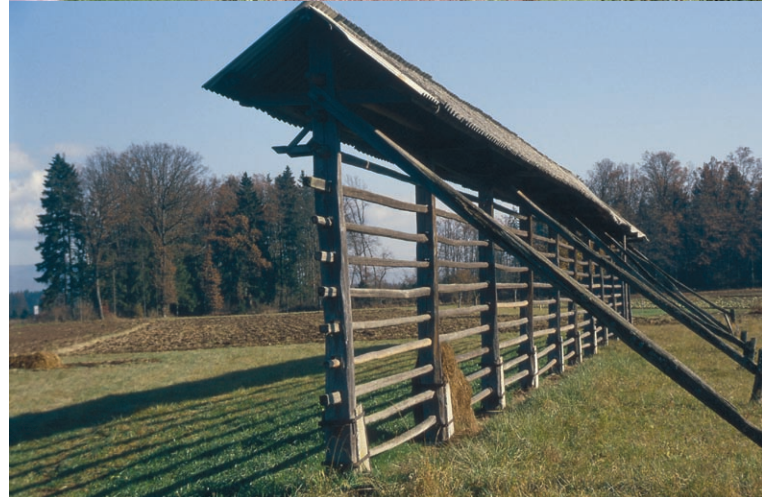
Slika 72: Najbolj običajen kozolec ima dve okni, čeprav najdemo tudi take z enim samim, medtem ko so daljši, na več oken, bolj redki (čeprav jih najdemo na primer v Škofljici tudi z osmimi).
